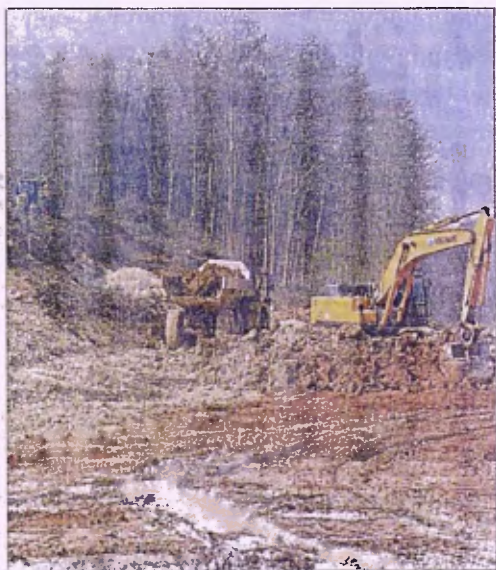
Les travaux de terrassement ont débuté depuis une semaine.
